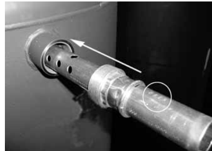
Estabelecer a ligação bem vedada da lança com a marcação “oben” (em cima) virada para cima
