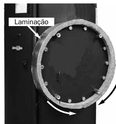
Coloque o revestimento isolante em volta do flange
