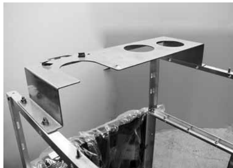
Montagem da chapa de consolas
