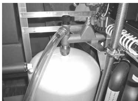
Vaso de expansão com tubo de aspiração
