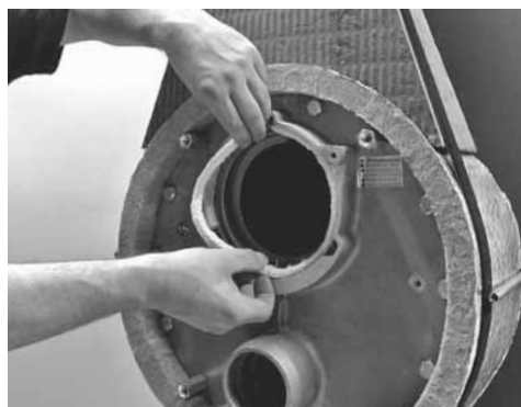
Instalação do cordão de vedação do queimador
