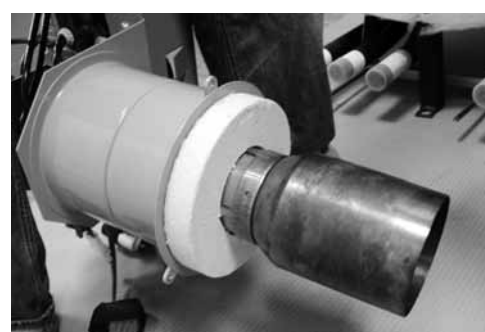
Instalação da pedra da entrada da caldeira e do tubo de chama
