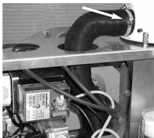
Montagem do tubo flexível de ventilação
